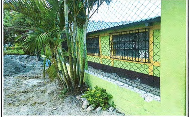
Foto 2: Mejoramiento Muro perimetral
