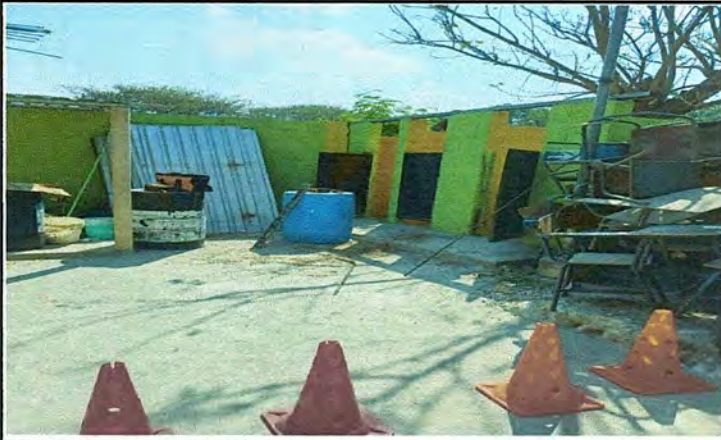
Foto 3: Mejoramiento de baños, piso, techo, azulejo
