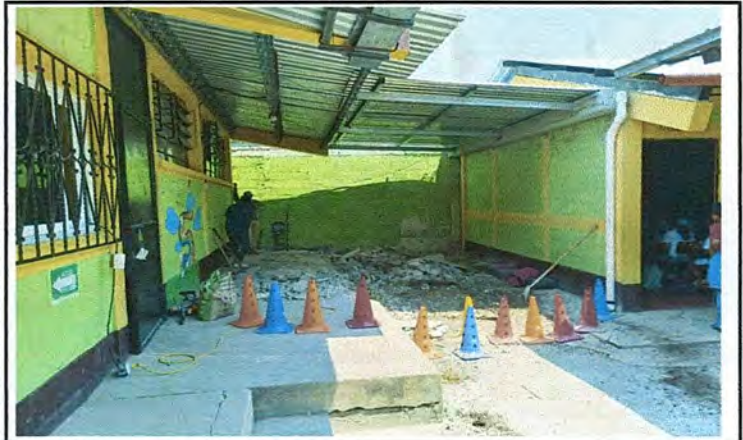
Foto 4: Mejoramiento techo tipo portico
