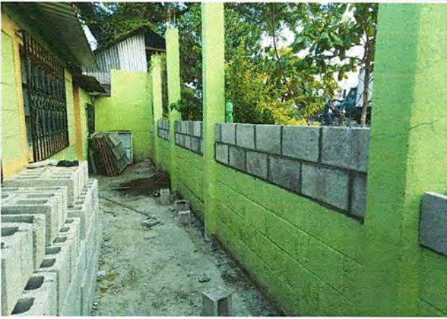
Foto 1: Mejoramiento de Muro perimetral
